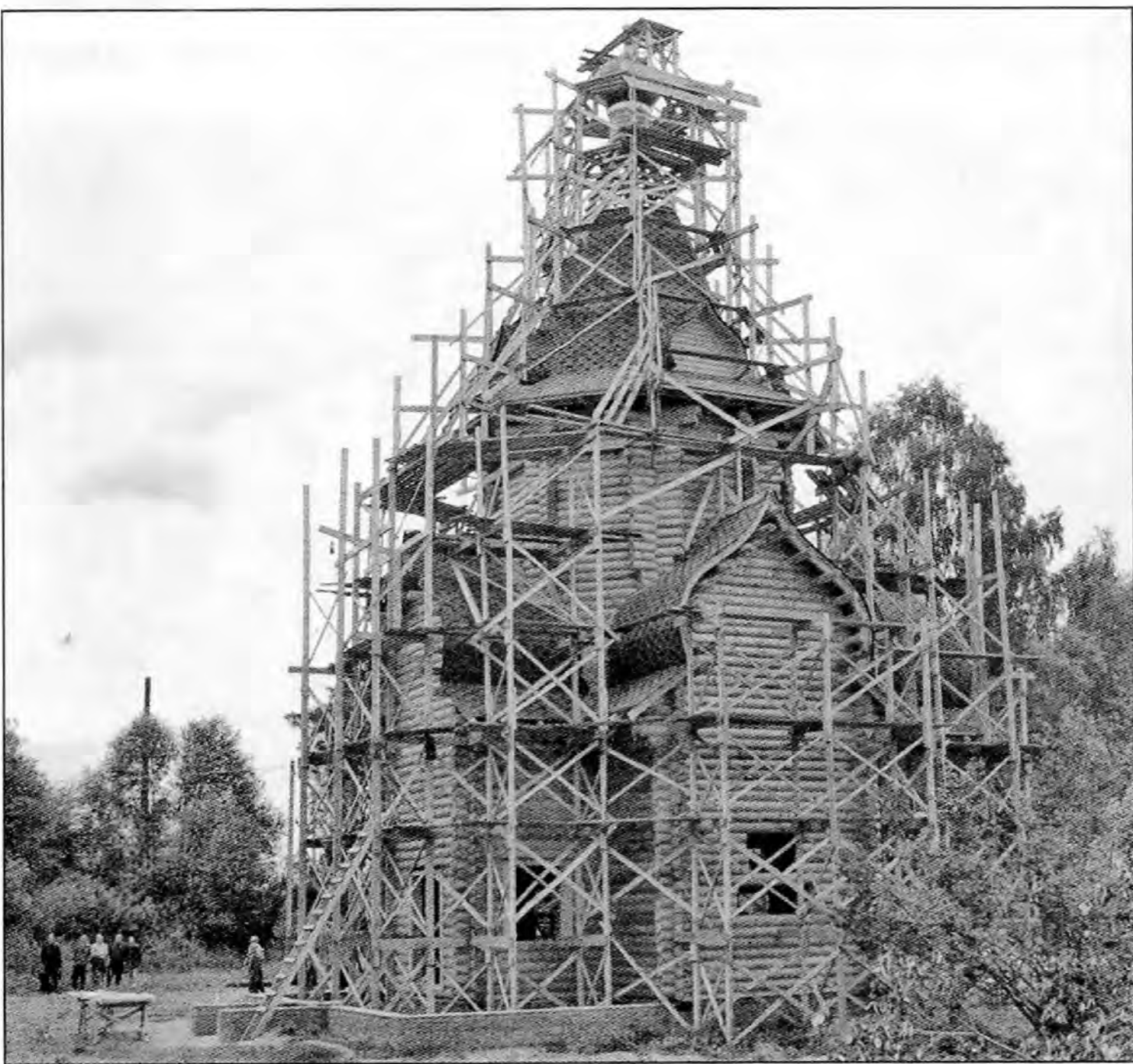
Строящийся Покровский храм в селе Адищево.
