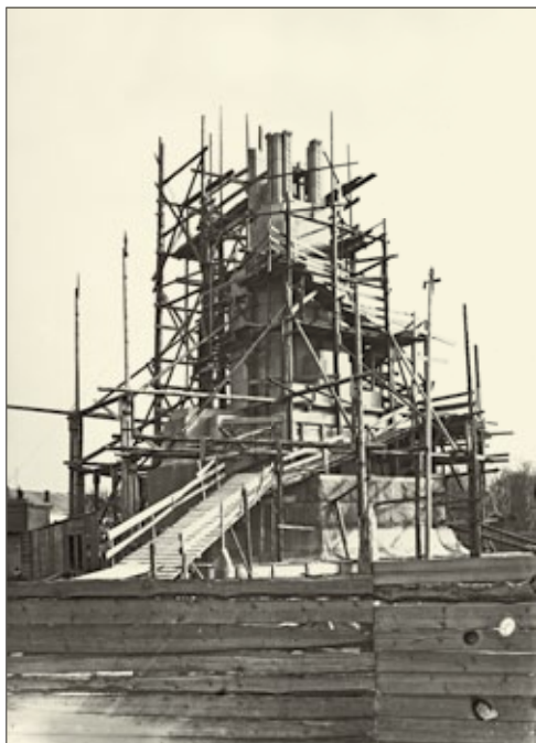
Строительство памятника. Фото середины десятих годов XX века.
