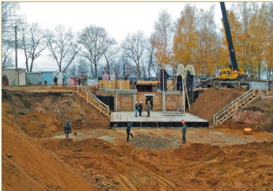
19 октября 2016 года. Подготовка площадки под строительство Богоявленского собора.
