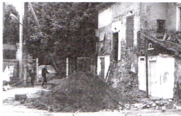
г. Кострома. Первый привратнический корпус Богоявленско-Анастасииного монастыря, переданный в 1991 году. Ремонтные работы.
