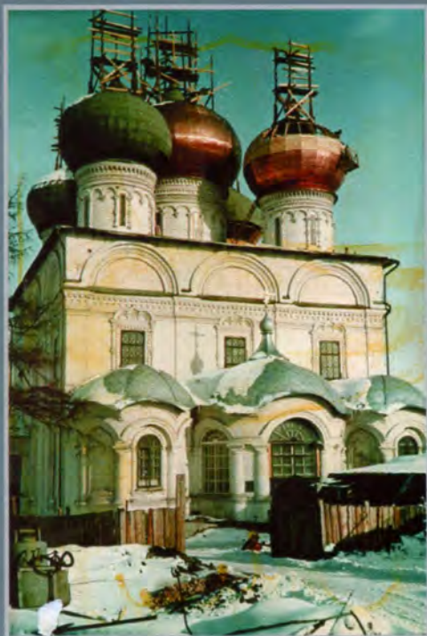
❖ Свято-Успенский собор в процессе реставрационных работ. 1988 год.
