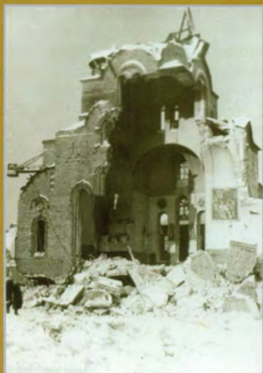
❖ Феодоровская Церковь г. Кирова после взрыва. Фото 1962 года.
