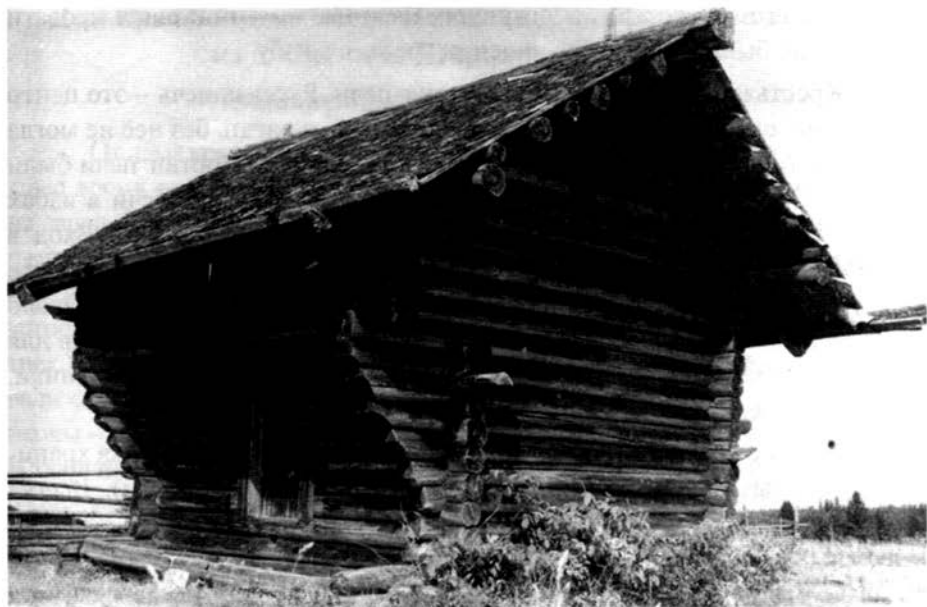
Амбар. Устройство крыши приёмом курицы под слуги. Межевской район.
