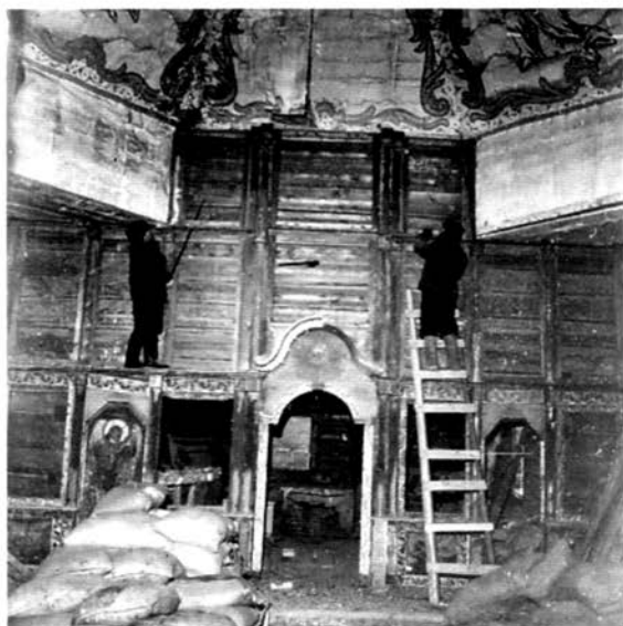
Демонтаж Ильинской церкви из с. Верхний Березовец Солигаличского района. Снятие холста с росписью. 1970 год.
