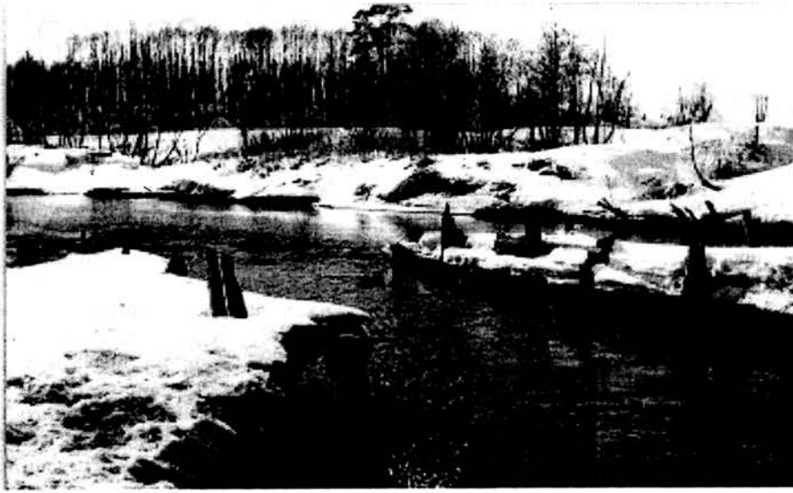
Разрушенный мост. Фото Г. Белякова. 1996 г.
