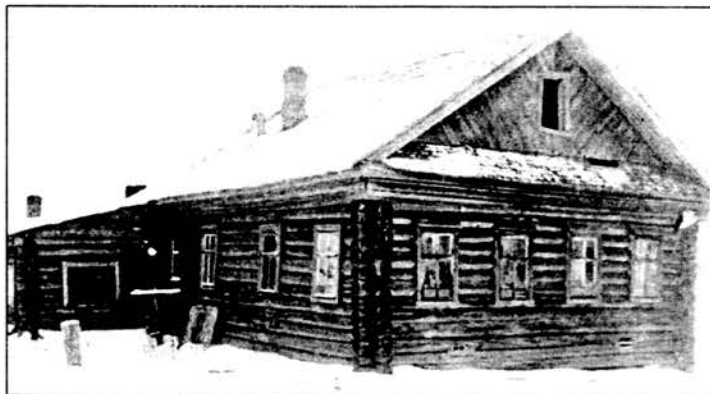
Маслозавод в д. Мормыш Нейского района, построен в 1933 г.
