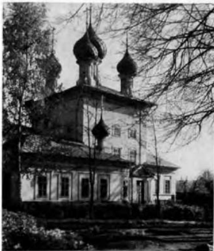
66. Церковь Иоанна Златоуста. 1791
