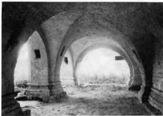
107. Село Красное. Церковь Богоявления. Галерея первого этажа
