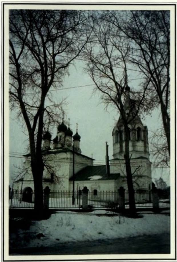
The state today Современное состояние
