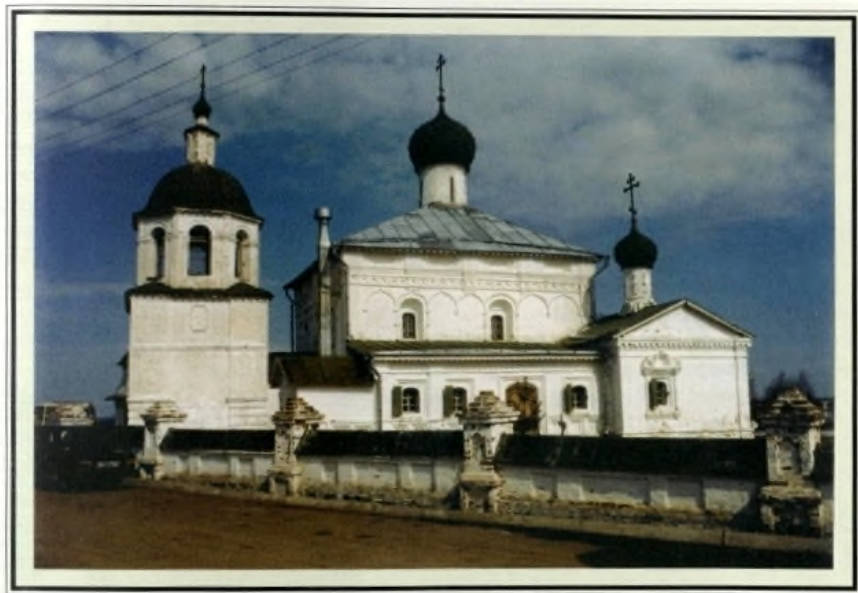
The state today Современное состояние
