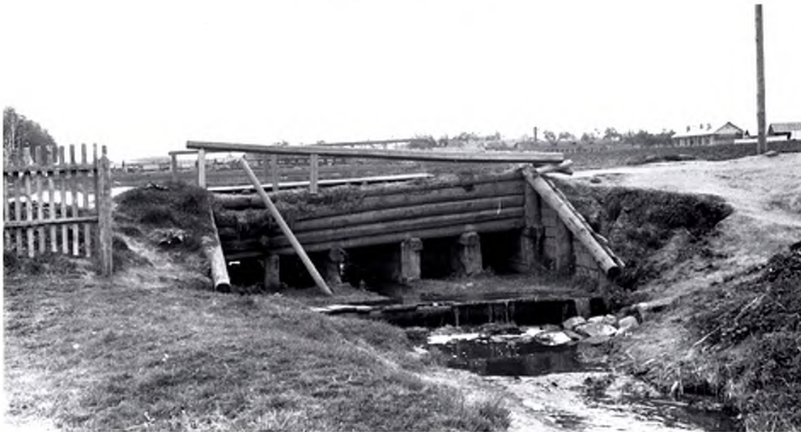
Мост через р. Черную на ул. Кооперации
