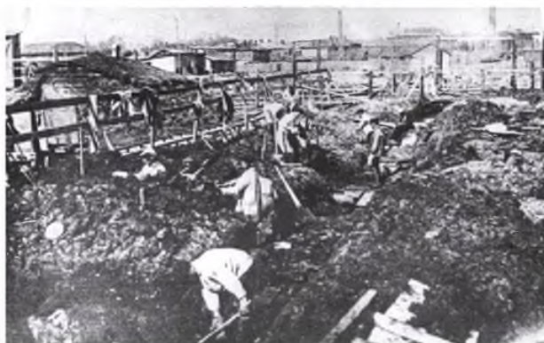
Начало строительства льнокомбината системы И. Д. Зворыкина
