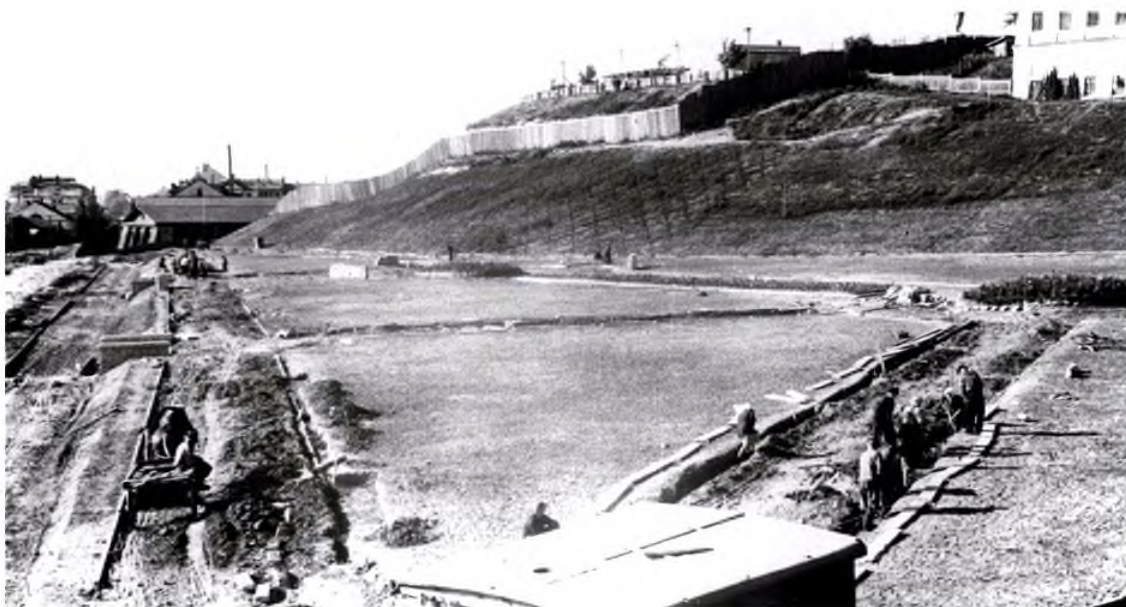
Начало работ по благоустройству сквера на набережной р. Волги
