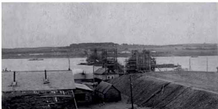
Строительство железнодорожного моста через р. Волгу
