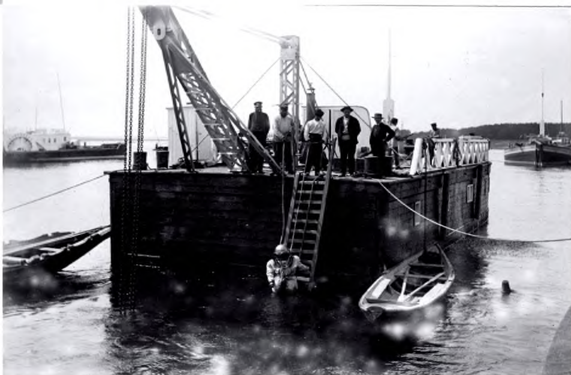
Водолазные работы на р. Волге
