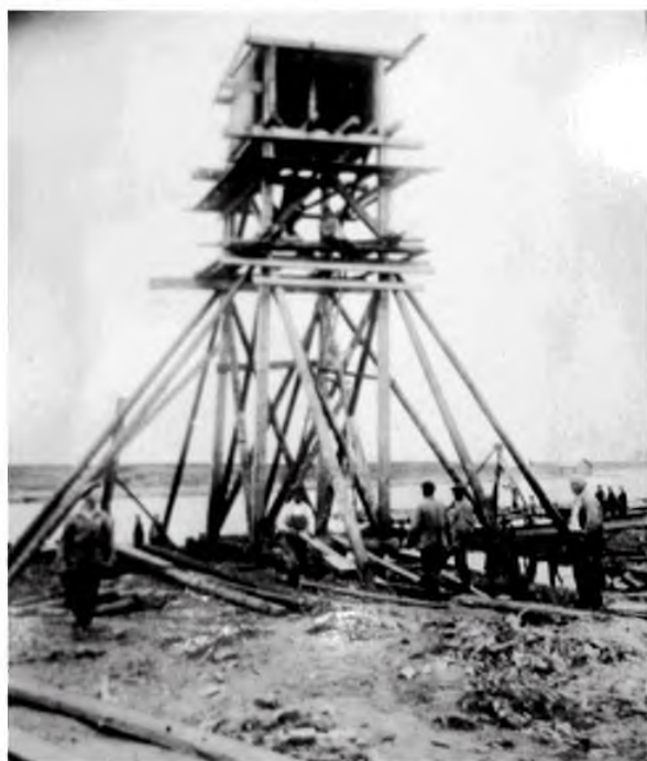
Буровые работы на площадке строительства ТЭЦ-1
