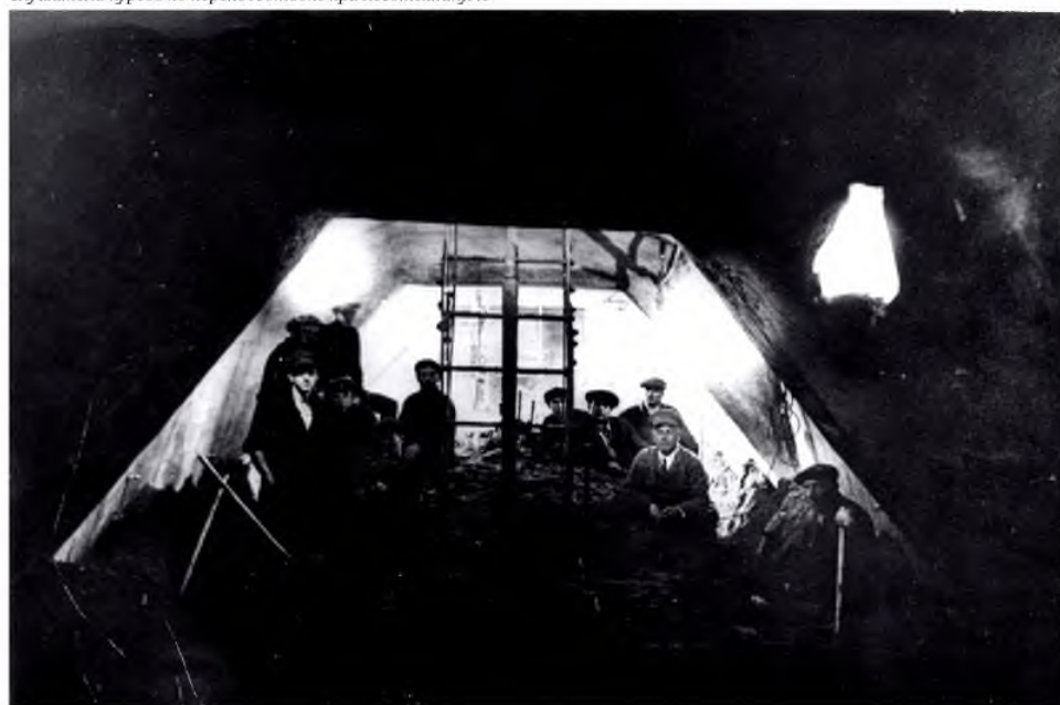
Строительство железнодорожного моста через Волгу. Работа в кессоне
