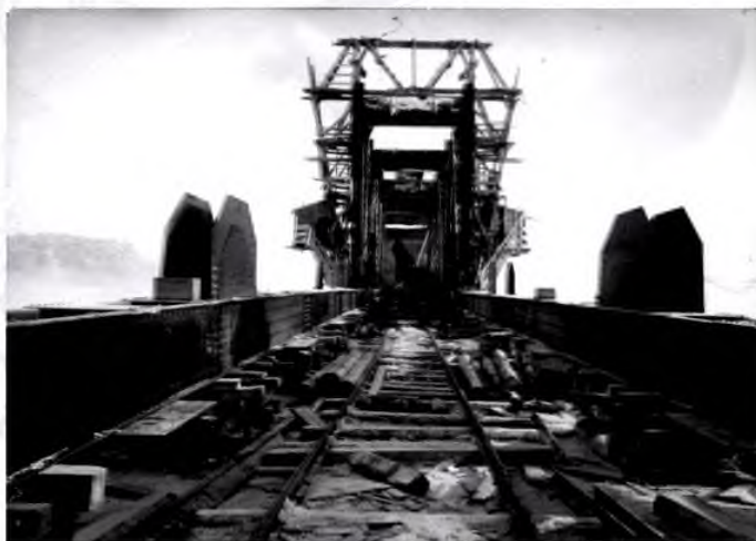
Строительство железнодорожного моста через р. Волгу: монтажные работы
