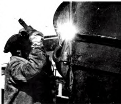
Первая электросварка на судомеханическом заводе. Электросварщик - Н.А. Еремин. 23 марта 1936 г.
