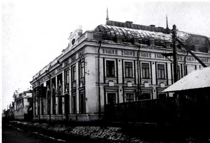
Здание бывшей дизельной электростанции
