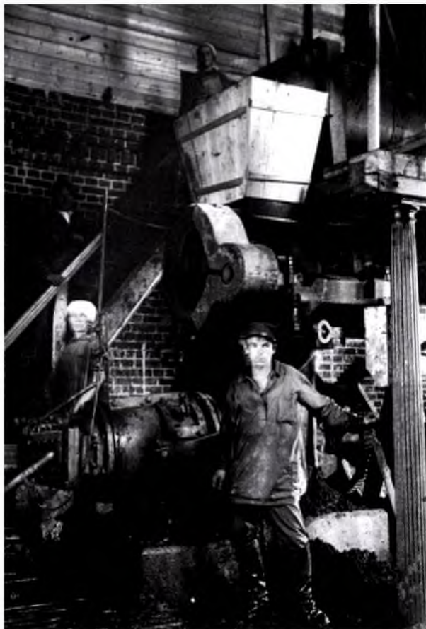
Костромской кирпичный завод: кирпичделательная машина
