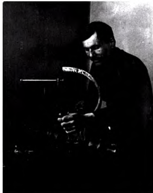
Слесарь горэлектросети А.М. Косоголов изготавливает «кошки» для лазания по столбам
