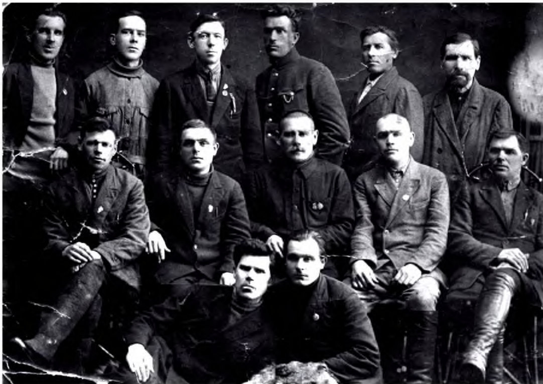
Инженерно-технические работники строительства железнодорожного моста через р. Волгу
