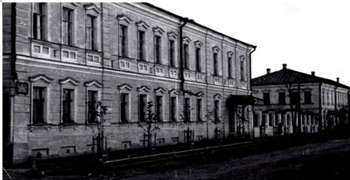
Здание сельхозинститута на ул. 1 Мая
