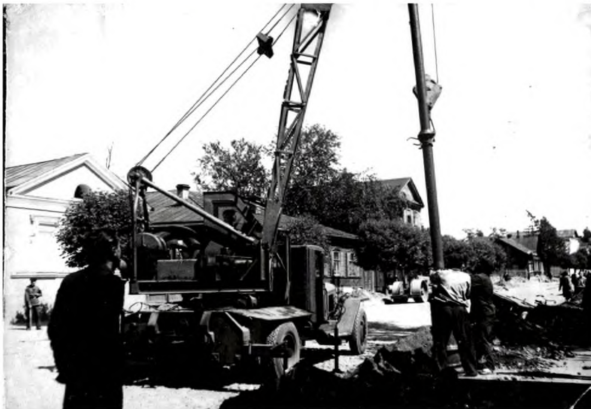
Монтаж опор уличного освещения на ул. Советской и ее благоустройство
