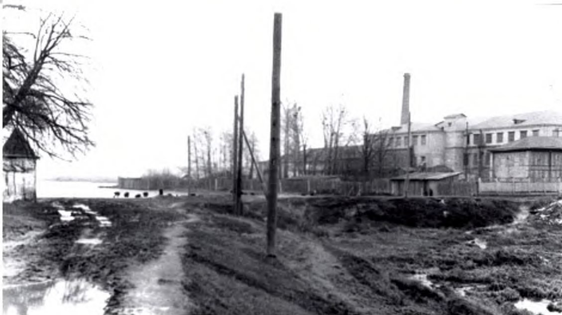
Плотина около фабрики «Октябрьская революция»
