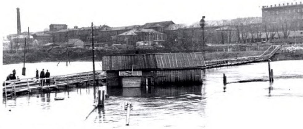
Наплавной мост через р. Кострому
