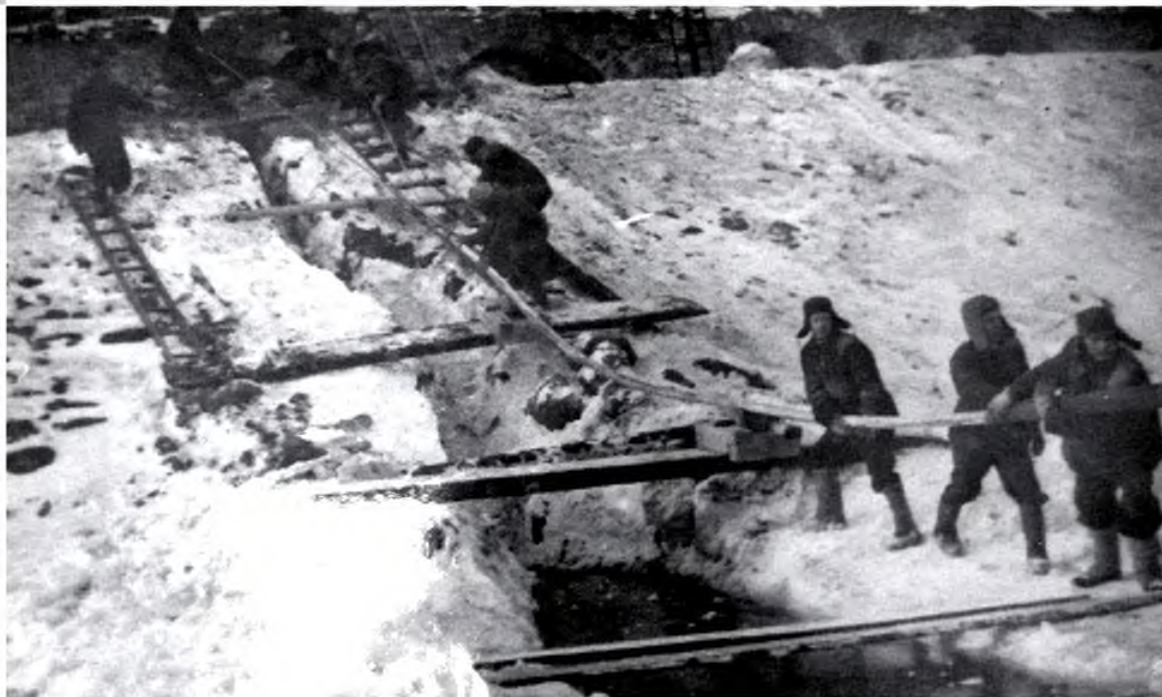
Прокладка кабеля через р. Кострому у стен Ипатьевского монастыря
