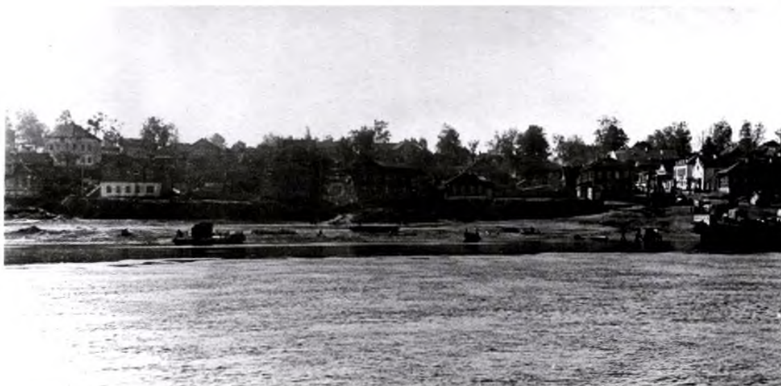
Набережная на правом берегу р. Волги
