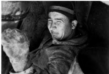
Работы по монтажу газопроводов ведет электросварщик СМУ «Розастрой» А. М. Андреев
