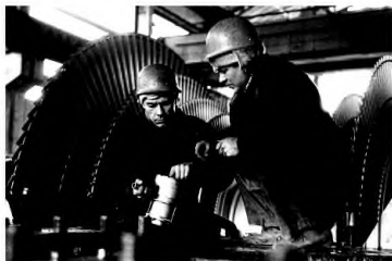
На монтаже оборудования в турбинном цехе Костромской ГРЭС
