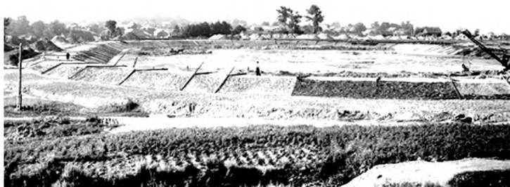
Начало строителства стадиона «Спартак»
