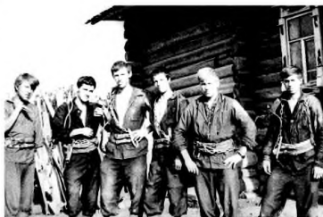
Студенческий стройотряд КТИ на электрификации Костромской области
