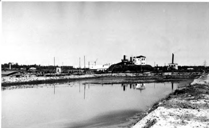
Васильевские очистные сооружения канализации
