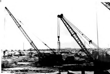
На стройплощадке ТЭЦ-2
