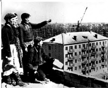
Строительство жилых домов на улице Советской
