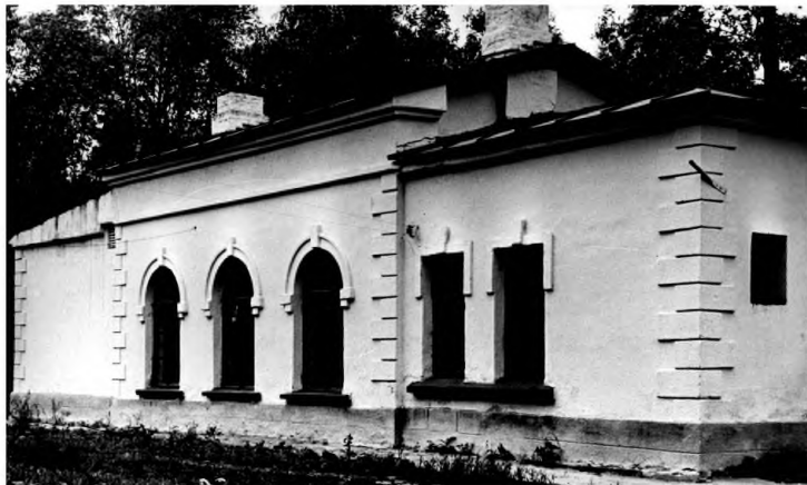
Здание водопроводной насосной станции «Якиманка»
