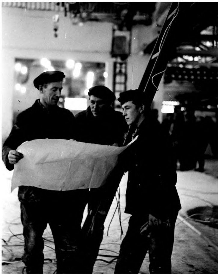
На монтаже оборудования завода деревообрабатывающих станков
