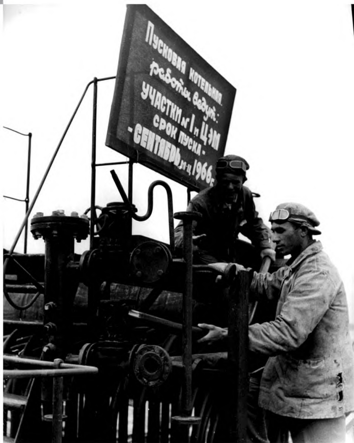
Работы на пусковой котельной Волгоградской ГРЭС
