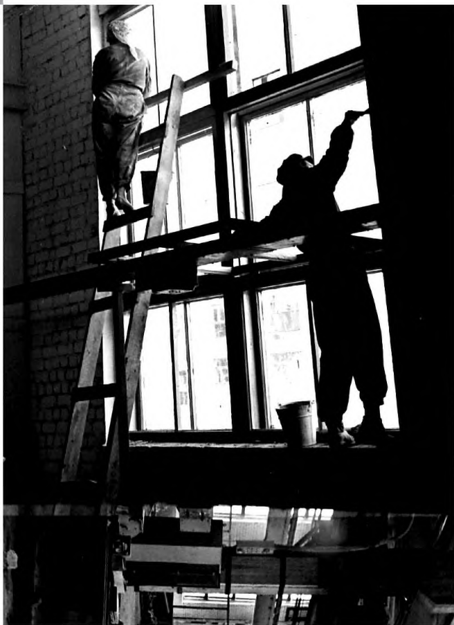
Отделочные работы в новом корпусе завода древеснообрабатывающих станков
