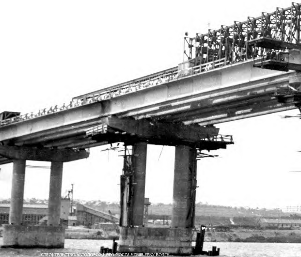
СТРОИТЕЛЬСТВО АВТОДОРОЖНОГО МОСТА ЧЕРЕЗ РЕКУ ВОЛГУ
