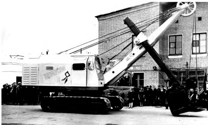
Экскаватор «Пионерский-11» около проходной завода «Рабочий металлист»
