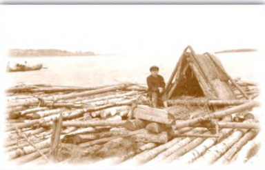
◄ Из жизни плотницков. Пища плотницков – картофель, каша, хлеб; на слэбе часто от сырости встречается плесень. Первая четверть XX в.
