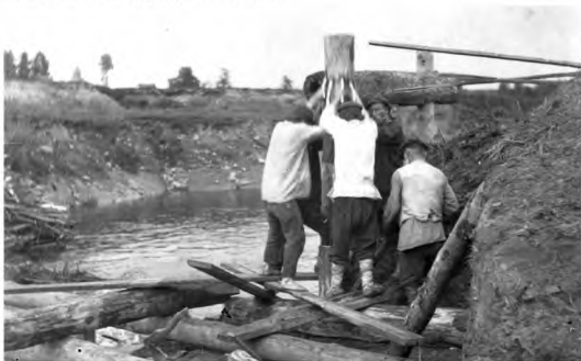
Строительство моста через р. Стёжеру (колхоз «Большевик»)
