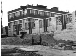
Строительство административного корпуса Красносельского ювелирного завода. 1970-е гг.
