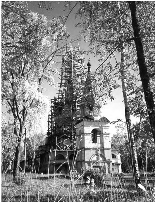
Церковь Боговlenia во время реставрации
