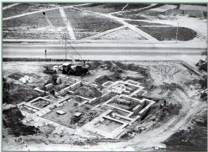
Начало строительства (вид сверху).
