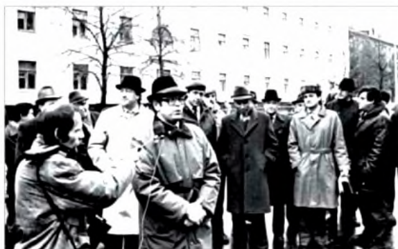
Планерка по строительству транспортной развязки на улице Советской через железнодорожные пути
