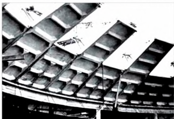
Уникальный монтаж купола нового цирка в Костроме (разработка института "Костромагражданпроект", главный инженер К.Н. Лиманцев)
