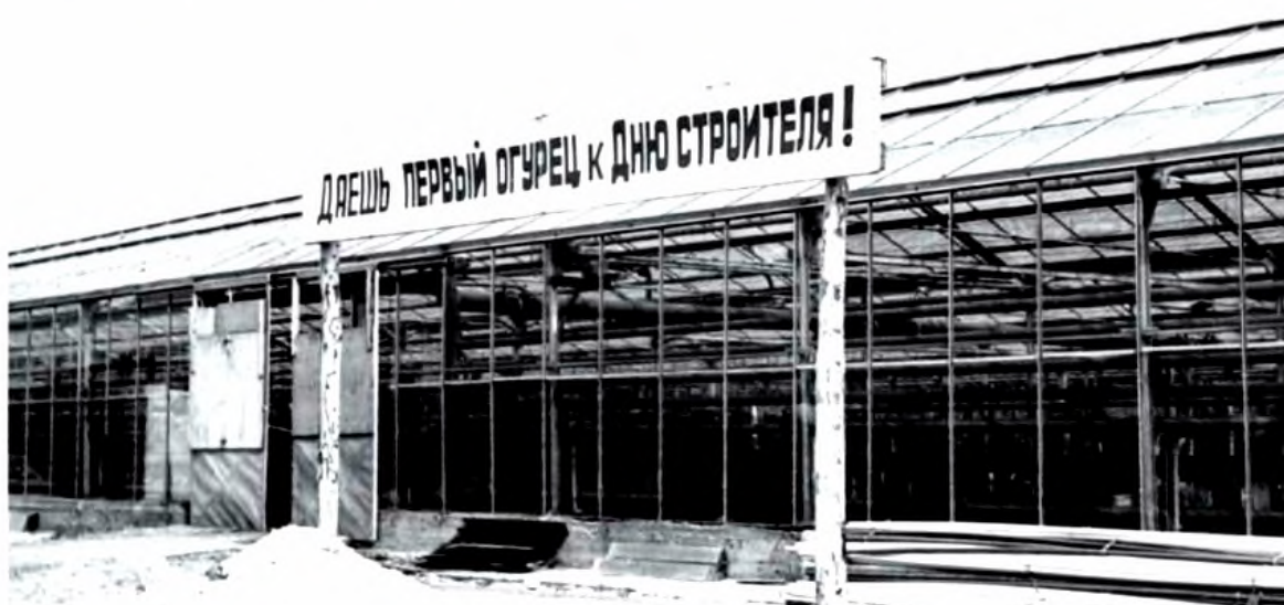
Строительство тепличного комбината
