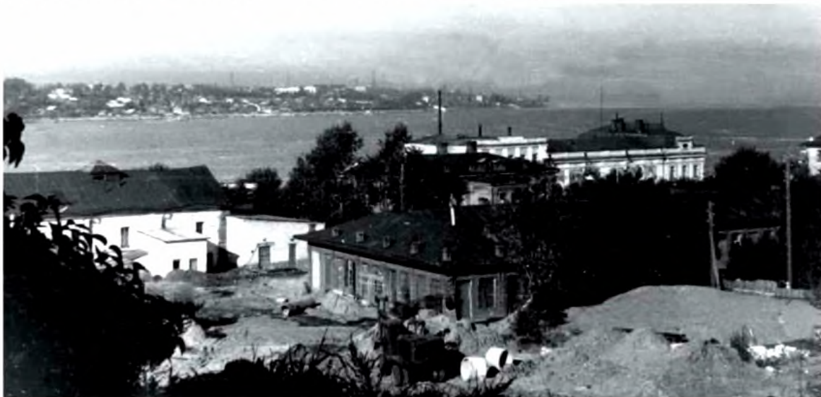
Здание реагентного хозяйства очистных сооружений водопровода (бывшие Рыбные ряды)
