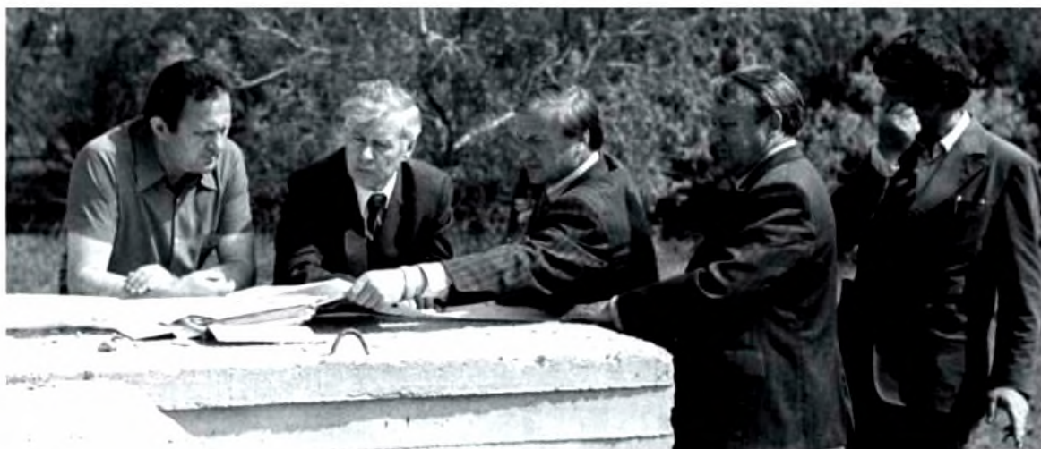
М.Ф. Спеглянин на строительстве пешеходного перехода
