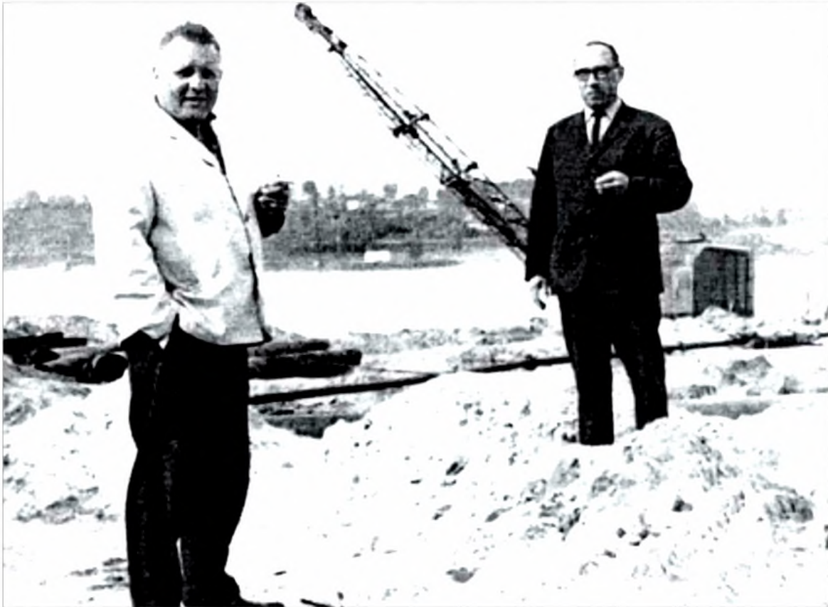
Н.П. Журавлев и Б.Ф. Александровский на строительстве очистных сооружений водопровода на ул. 1 Мая
