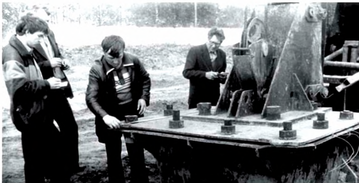
Испытание новой техники — установка по вытрамбовыванию фундаментов, 1984 год
