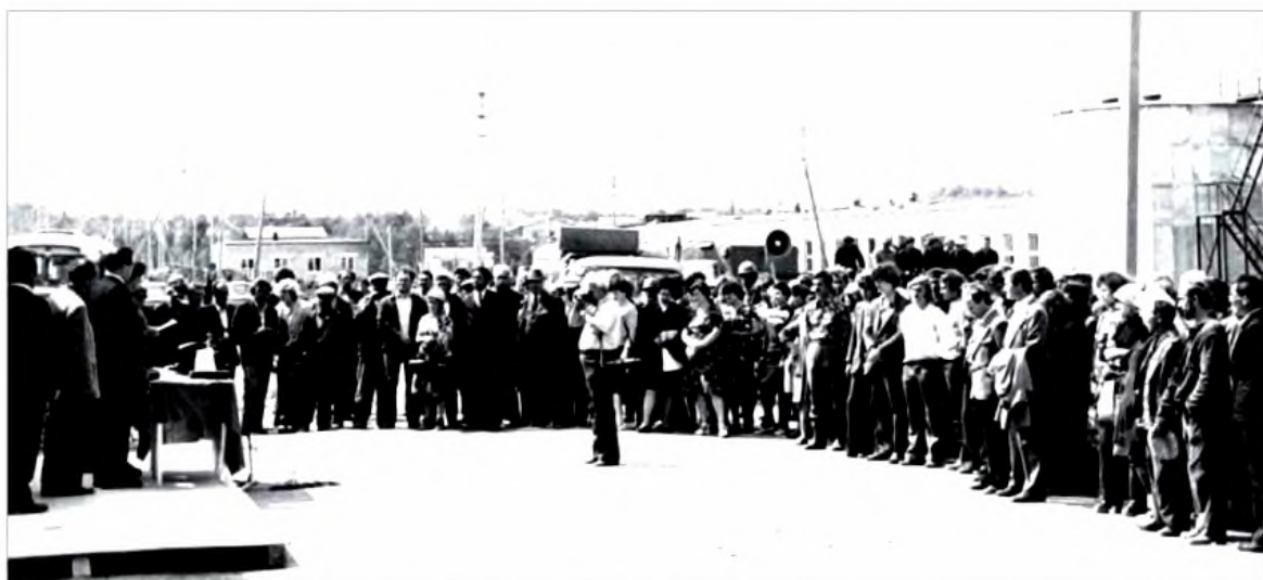
Торжественный митинг по случаю завершения строительства птичника
