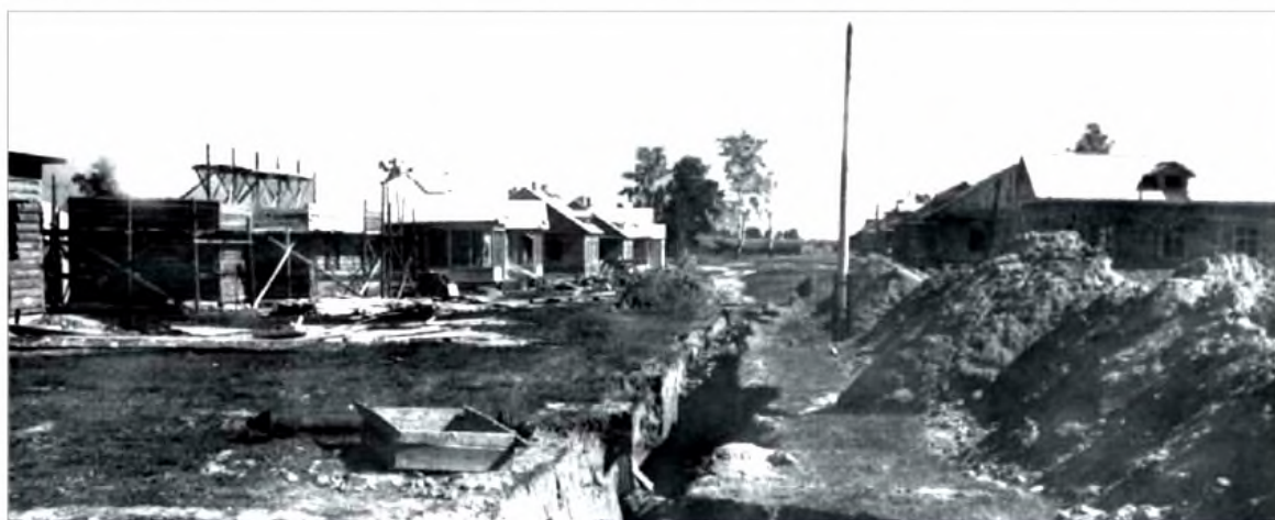
Прокладка коммуникаций в микрорайоне Октябрьский
