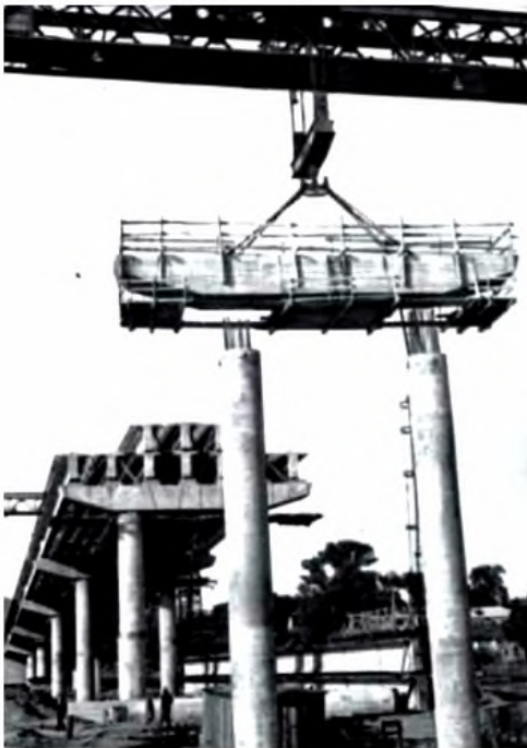
Монтаж конструкций моста через реку Кострому
