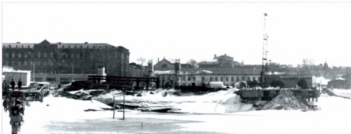
Стройплощадка моста через реку Кострому
