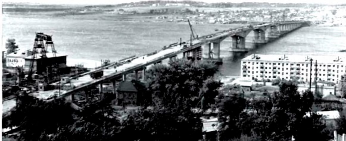
Близится к завершению строительство моста
