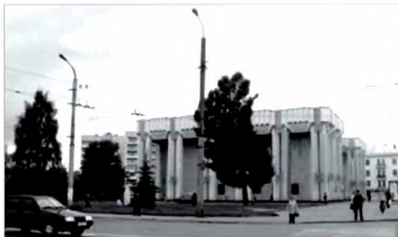
Здание филармонии после реконструкции
