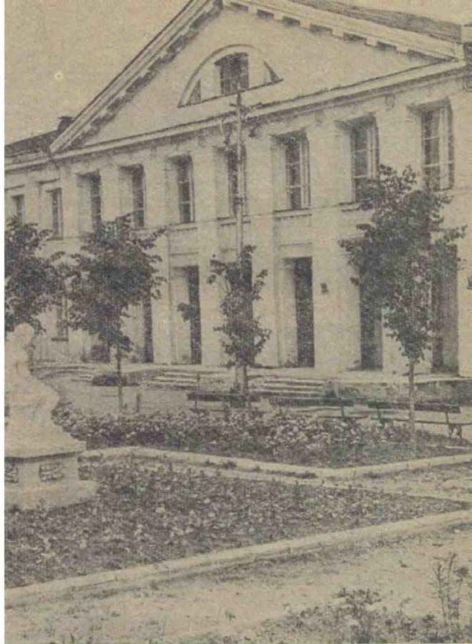
Дом культуры завода «Рабочий металлист»
