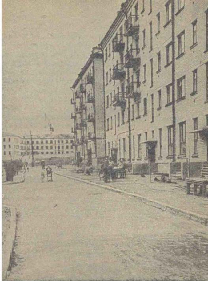
Жилостроительство в Заволжском районе
