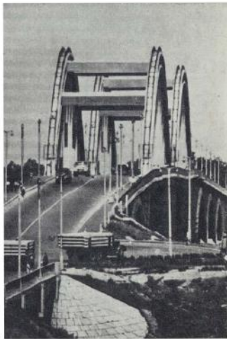
Мост через Волгу
