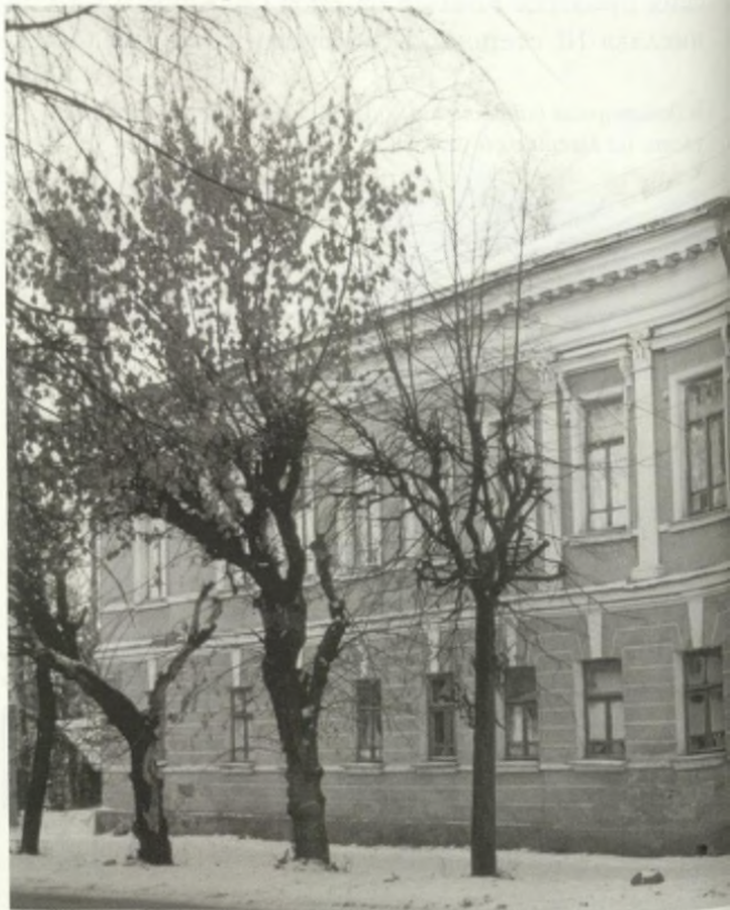
Мианская ул. (Островского, 40)
