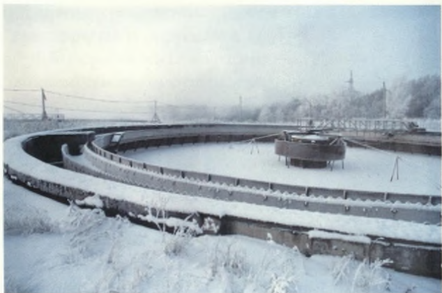
Коркинские очистные сооружения
