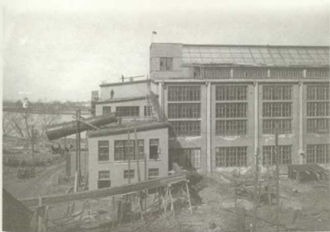
Строительство ТЭЦ-1. 1929 г.
