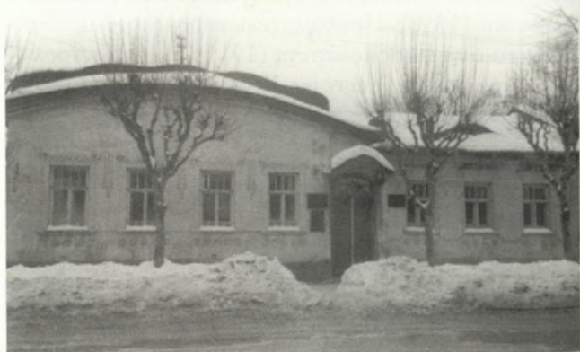
Александровская ул. (Свердлова, 10)
