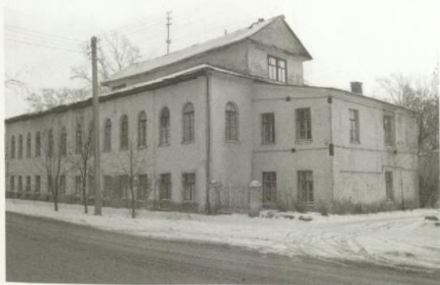
Александровская ул. (Свердлова, 26)
