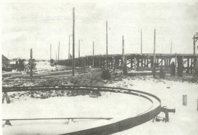
Строительство железнодорожного моста
