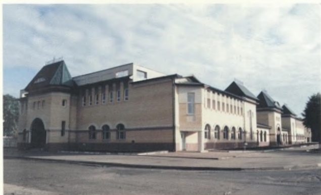
Торгово-выставочный центр «На Сенной» Набережная реки Волги после реконструкции
