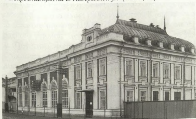
Электростанция на В. Набережной ул. (1 Мая, 3а)
