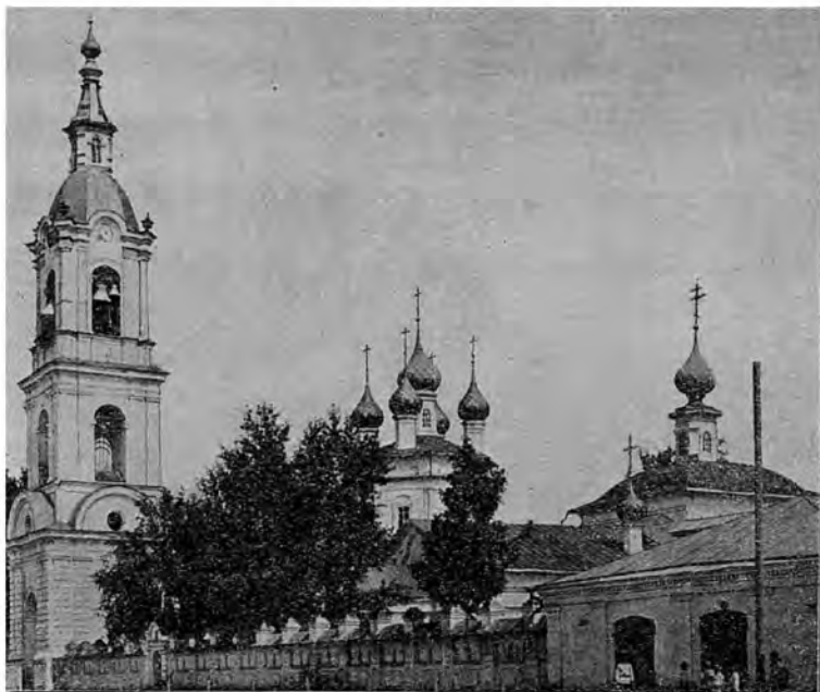
Рис. 185. Путежь. Воскресенская церковь.
