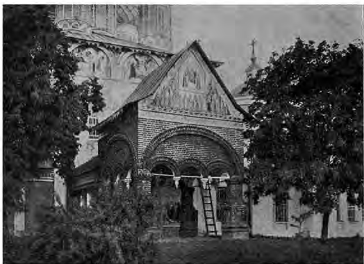
Рис. 117. Нерехта. Крыльцо Владимірской церкви.
