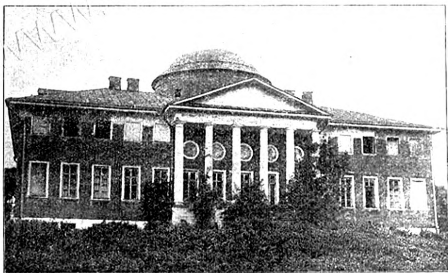
Рис. 47. С. Алёшино. Помѣщичій домъ.
