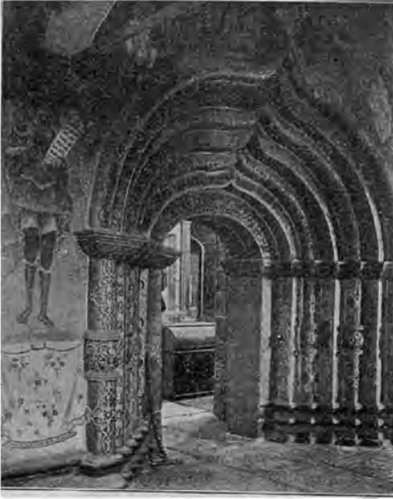
Рис. 15. Главный входъ (рис. 16), съ другой стороны.
