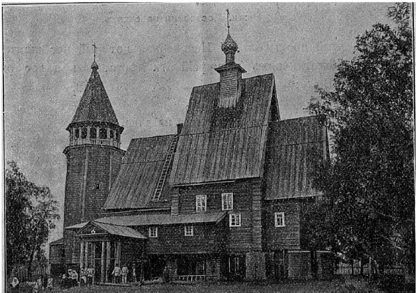
Церковь въ с. Спасъ, построенная на столбахъ.
