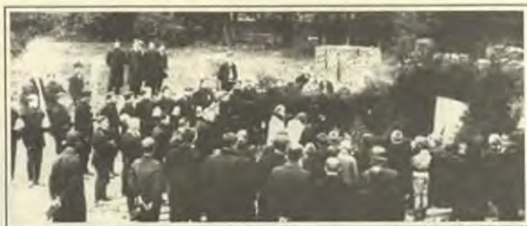
Закладка здания Добровольного пожарного общества Фото Д.И.Правичникова. 1910 г.
