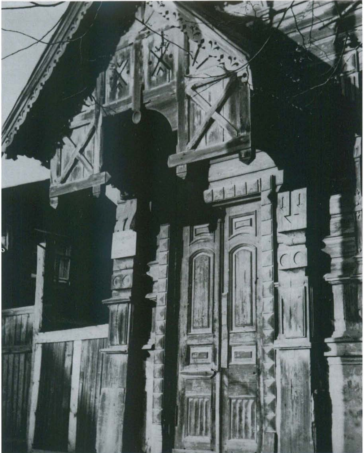
Крыльцо (Энгельса, 21) A porch (Engels str., 21)
