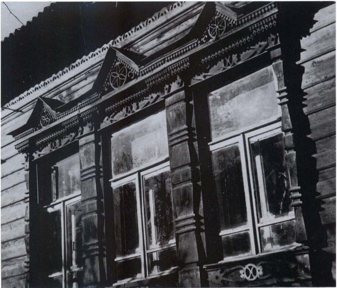
Тройной наличник дома (пр. Текстильщиков, 35) A triple window casing (Avenue Prospect Textilshikov, 35)
