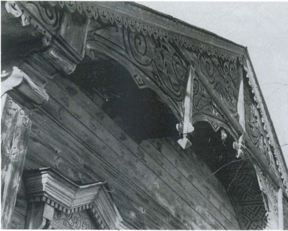
Фронтон дома (ул. Козуева, 47) A house pediment (Kozuyev str., 47)
