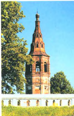
Шатровая колокольня церкви Бориса и Глеба
