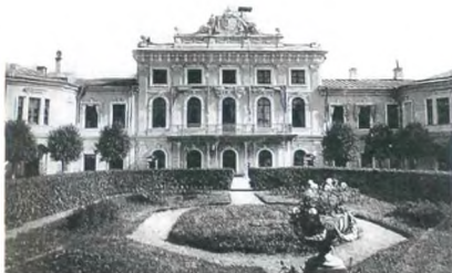
Путевой дворец Екатерины II. Центральная часть фасада
