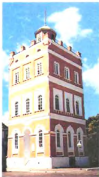
Водонапорная башня. Постройка XIX в.
