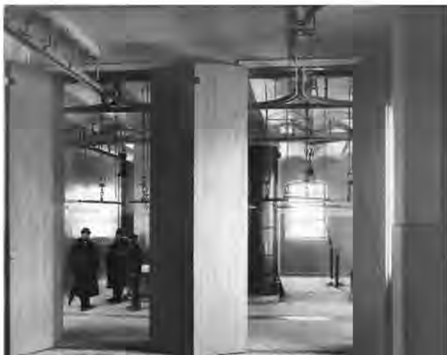
Городская бойня, внутренний вид зала для охлаждения туш. Крайний слева – автор проекта архитектор Н.И. Горлицын. Нач. XX в.
