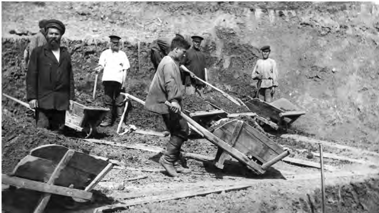
Земляные работы при строительстве земских дорог. Фотограф А.А. Макаревский. Нач. XX в.
