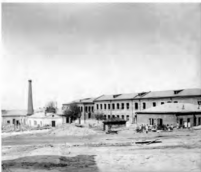
Строительство мастерских Чижовского училища. Фотограф А. Ф. Шмидт. 1890-е гг.
