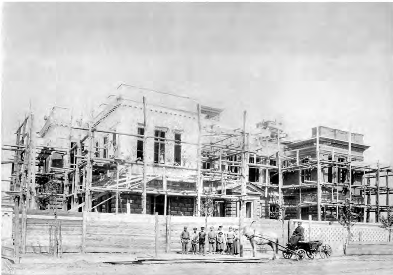
Строительство здания среднего механико-технического училища им. Ф.В. Чижова. Фотограф А.Ф. Шмидт. 1890-е гг.
