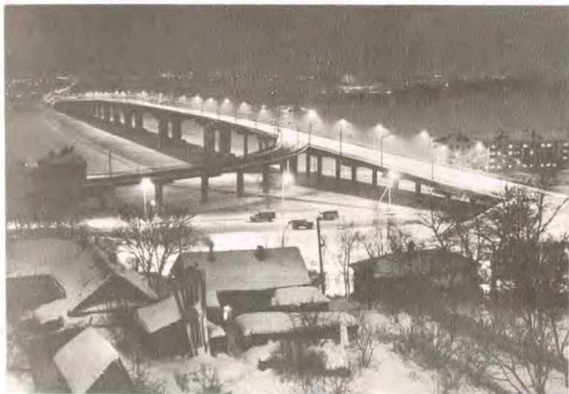
Мост через р. Волгу
