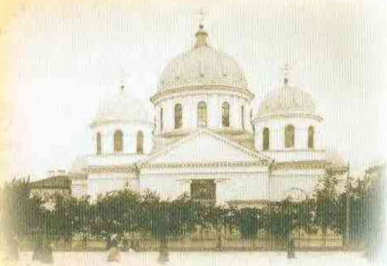
Входоиерусалимская Знаменская церковь. 1900-е гг. Фотография Н. Г. Матвеева
