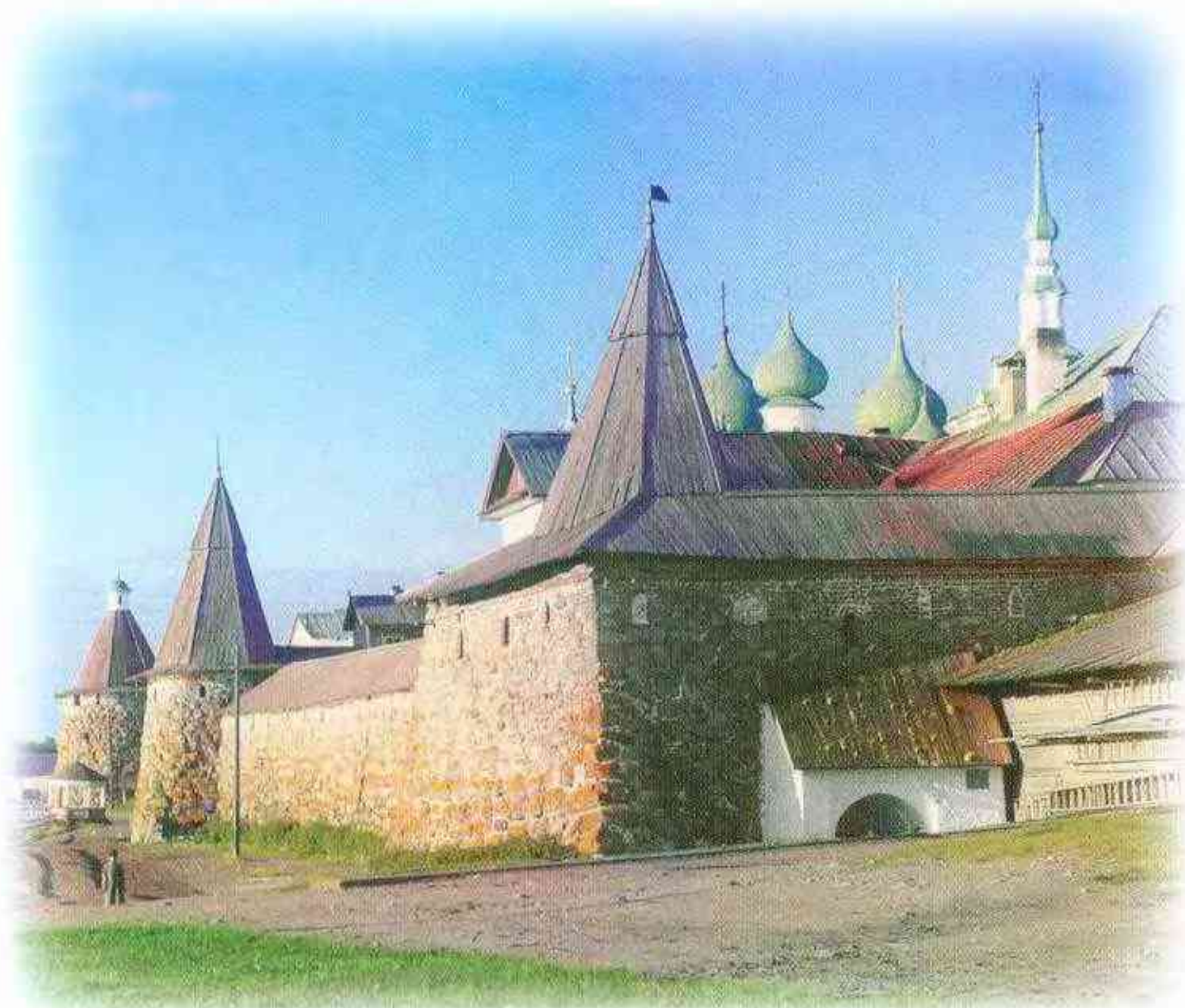
Соловки. На переднем плане Пристенок с Квасоваренной и Поваренной башнями, дальше Архангельская башня. Справа купола и колокольня Успенского собора. Слева берег Святого озера. Фотография С.М. Прокудина-Горского, 1916 г.
