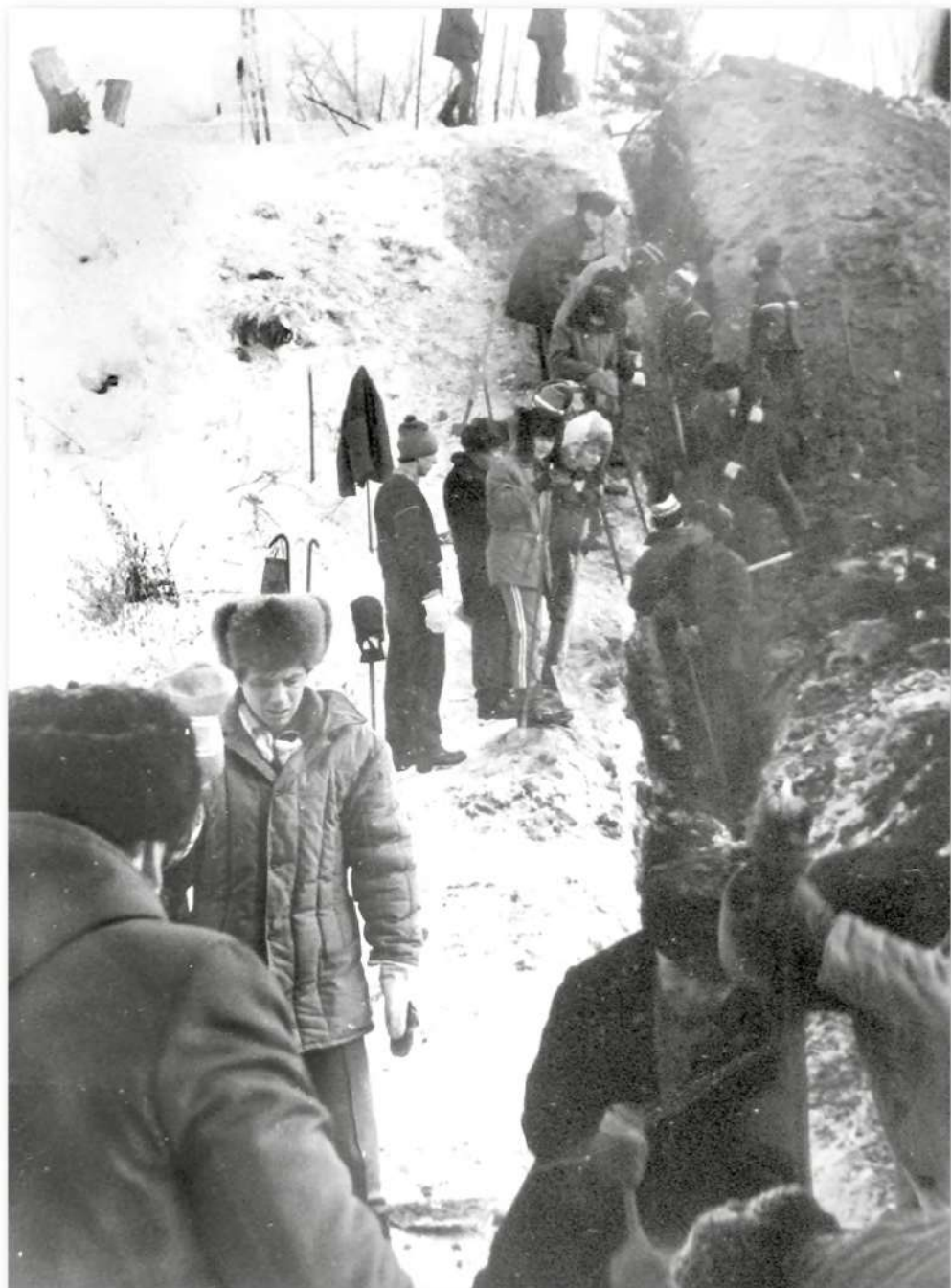
Декабрь 1988 года. Рытье траншеи для прокладки газопровода к Никольской церкви
