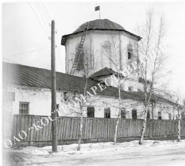
Благовещенская церковь до начала реставрации. ОАО «Костромареставрация»
