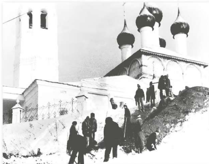
Копка траншеи для газопровода к Никольскому храму. Декабрь 1988 г.
