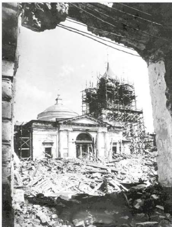
Реставрация Владимирского храма. Фото нач. 1990-х гг.
