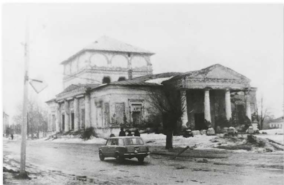
Никольская церковь. Фото начала 80-х годов XX в.
