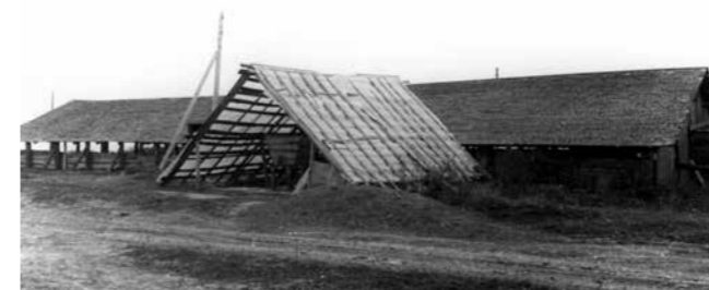
Житница в д. Башуриха Троицкого с/с. Перестроена под двор.
