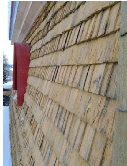
Рис. 10. Dranka, уложенная на крышу
