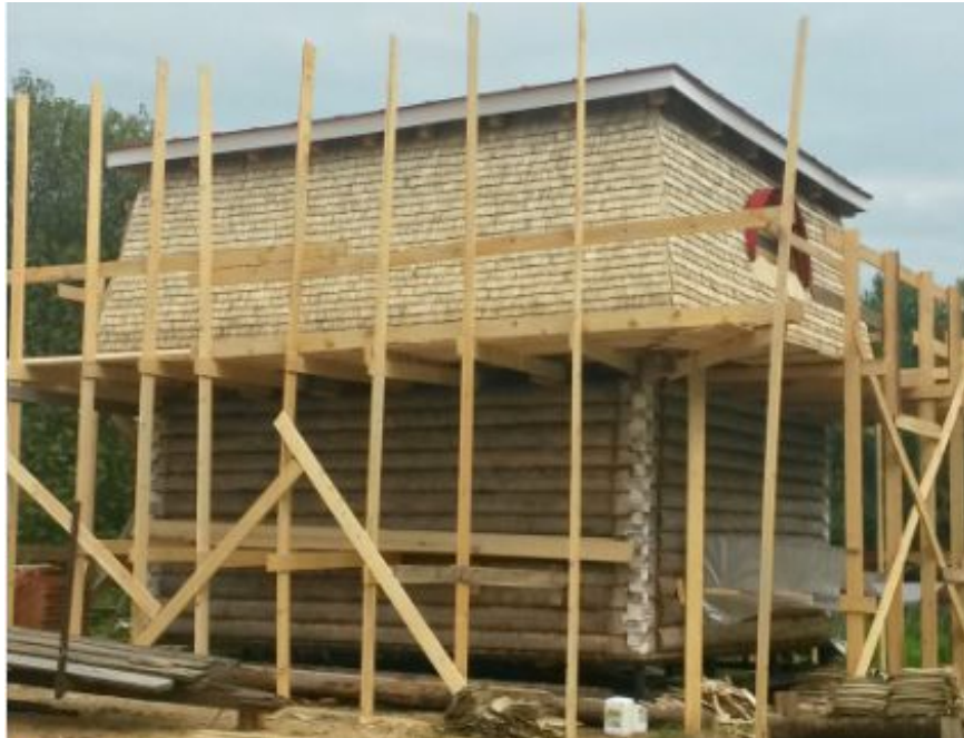
Рис. 9. Северный флигель «в лесах» для укладки drankи на крышу
