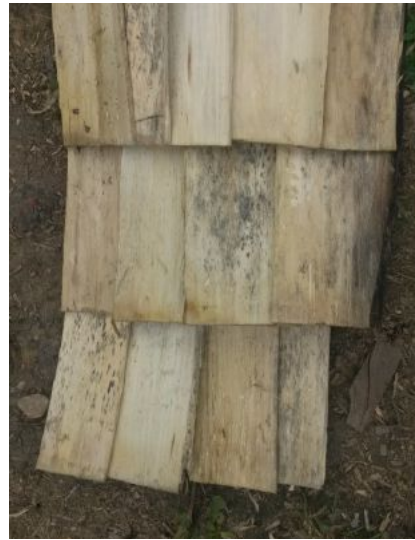
Рис. 8. Порядок укладки drankи
