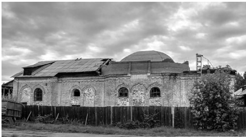
Котельнич. Александро-Невская церковь (бывший Котельничский домзак): начало восстановления. Фото Д. Анисимова. 2015 г.
