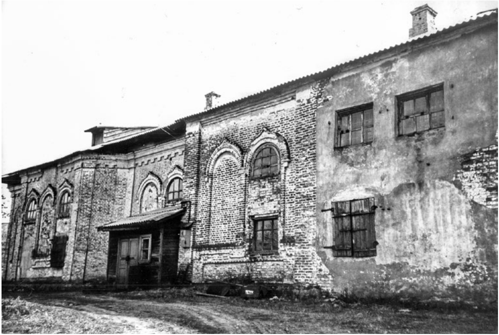
Здание бывшей Александро-Невской церкви, в которой с конца 20-х годов размещался Котельничский дом заключения (домзак). Фото 1960-х гг.
