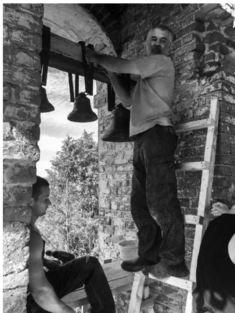
10 августа 2017 года. Установка колоколов на колокольне Никольской церкви
