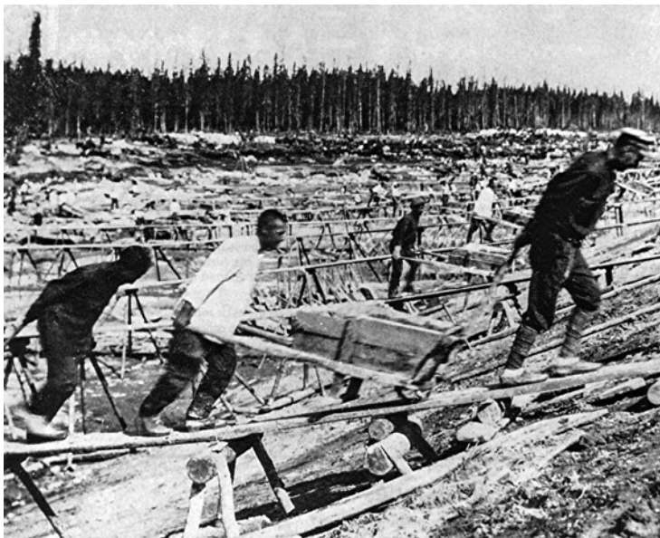
На строительстве Беломорско-Балтийского канала имени Сталина. Фото начала 1930-х гг.
