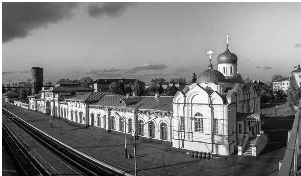
Буй. Никольская («железнодорожная») церковь при Буйском вокзале. Современное фото
