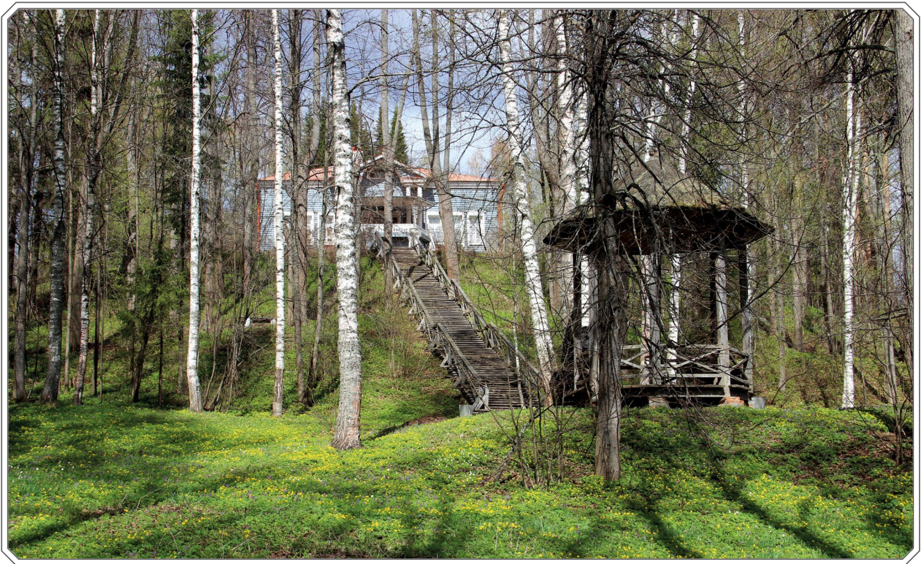
Вид от одноэтажной беседки на южный фасад усадебного дома. 2017 год.
