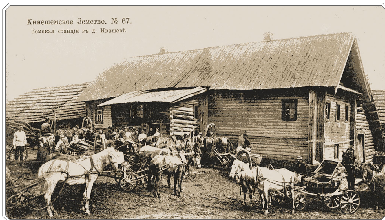
Земская станция в д. Ивашево. Нач. XX века.
