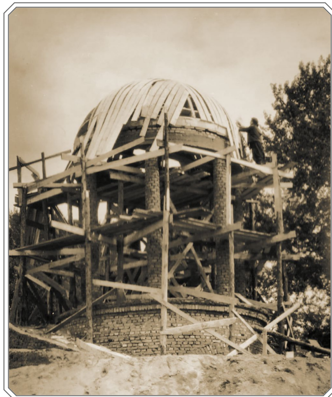
Строительство беседки на волжской набережной в г. Костроме. 1956 год.
