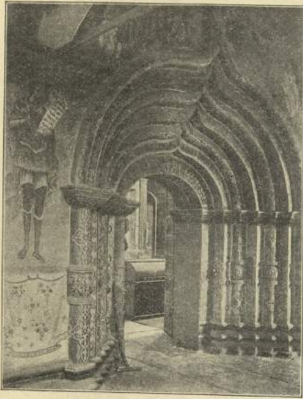
Рис. 15. Главный входъ (рис. 16), съ другой стороны.
