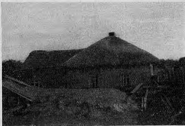
Рис. 19. Кустарный кожевенный заводъ въ сл. Алексѣевкѣ, Воронежской губ. (1911 г.).
