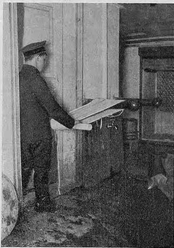
Рис. 4. Разравниваніе пряжи на швиляхъ.
