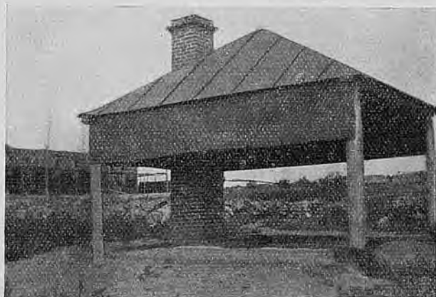
Рис. 27. Печь для варки лака и мыла. (Болх. Шк. Инстр. кож. пр.).
