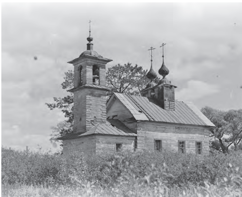
Ил. 1. Кашин. Церковь свв. Иоакима и Анны после перестройки 1830-х гг. Вид с юго-запада. С фото В.А. Колотильщикова. Нач. XX в.
