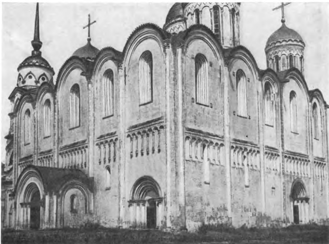
Современный вид Успенского собора во Владимире после перестройки 1185 — 1189 годов (западный и восточный фасады).
