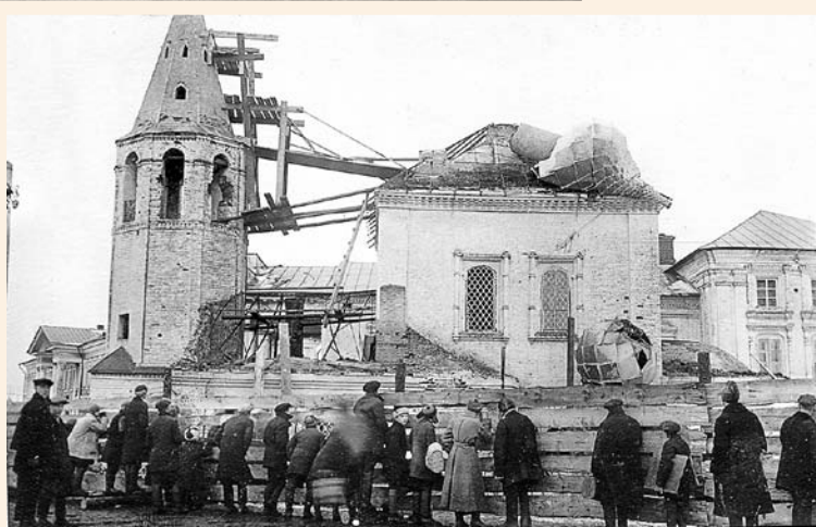
Разборка Воскресенской церкви на площадке. Фото 1930 года.
