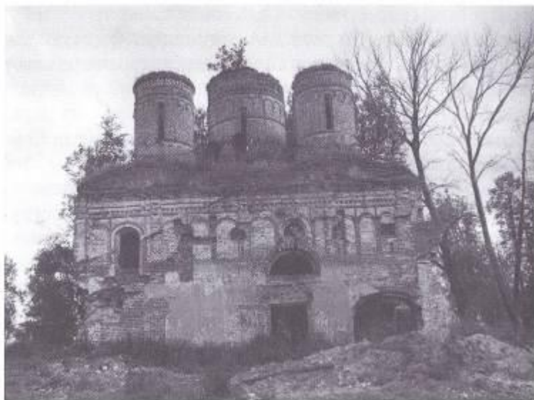
Южная стена четверика Спасо-Преображенского собора. Видны следы пристройки Сергиевской церкви. Справа арка, в которой стояла рака преподобного Геннадия. 1980-е. КИХН
