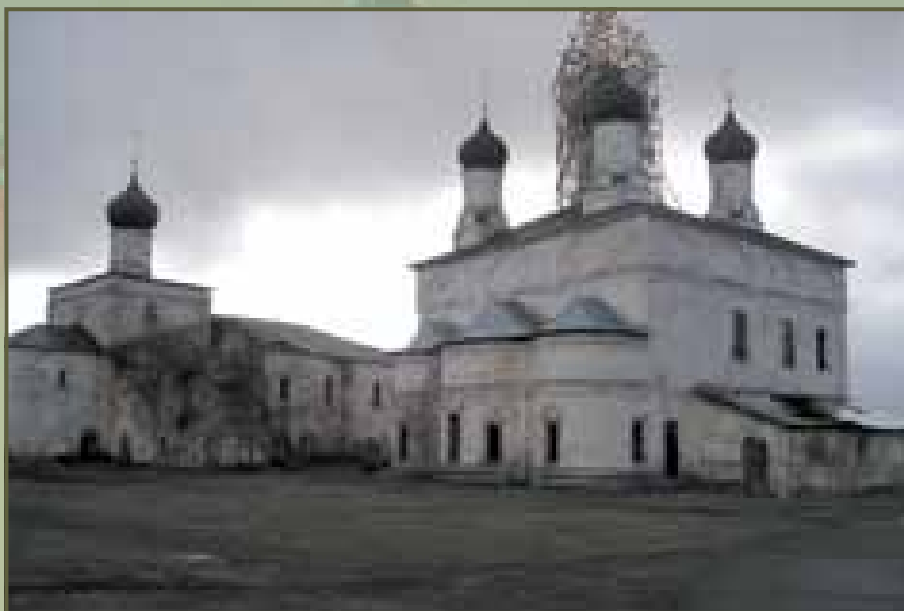
Макарьевский монастырь в ходе реставрационных работ. Фото 2004 года.
