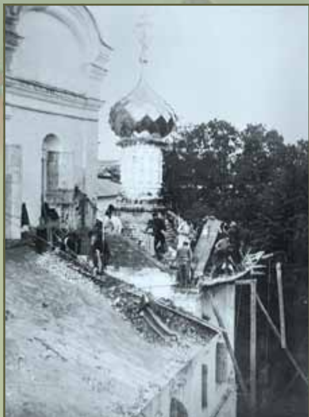
Троицкий собор в процессе реставрации 1960-1970-х годов. Вид с юга.
